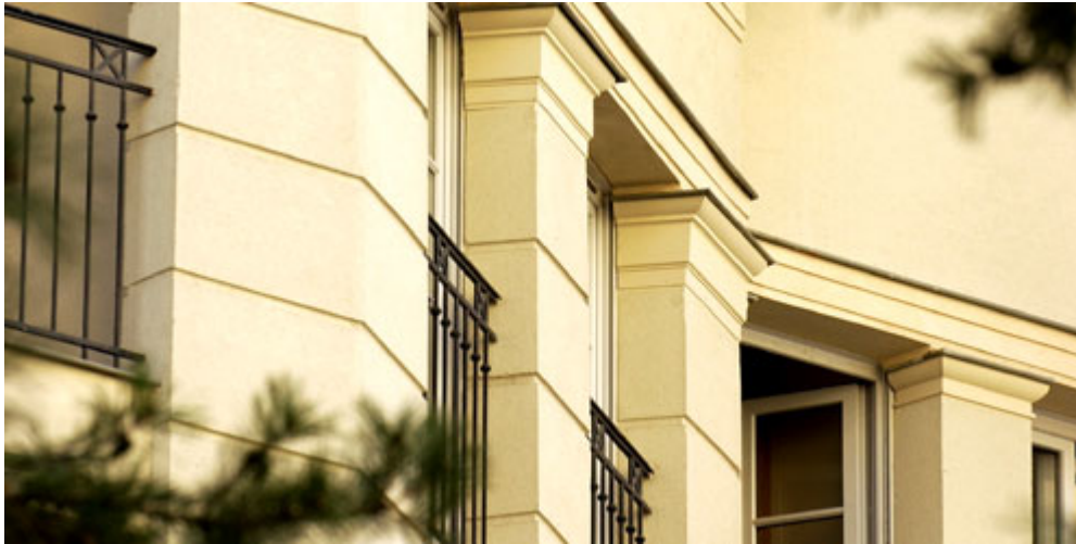
Isolation par STO SAS avec modénatures isolantes
