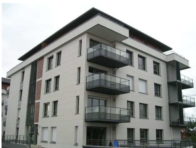
Bardage CAREA avec balcons à faibles ponts thermiques
