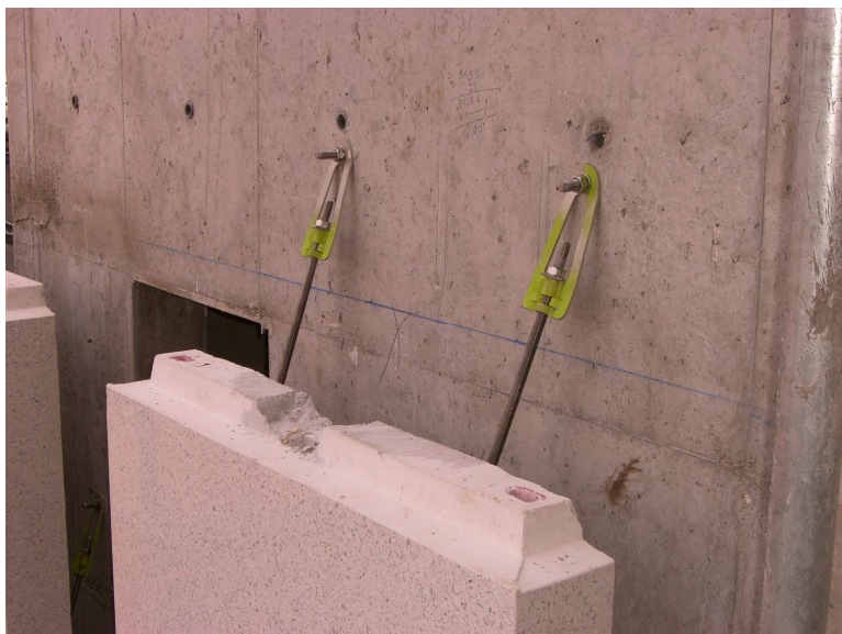
FIXINOX attache du voile extérieur librement dilatable
