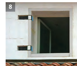
Habitat collectif rénové en enduit mince sur isolant PSE, Courbevoie (Zolpan)
