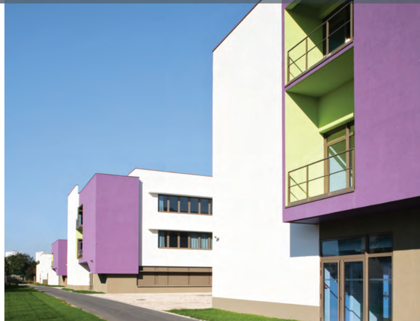
Ci-dessus : Les Lycées Samuel de Champlain, Chennevières s/Marne. Isolation Thermique Extérieure sous enduit épais (Saint-Gobain Weber)
