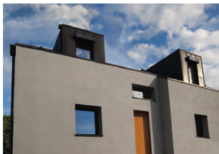
Alors que sur la façade nord (ci-dessus), le nombre d'ouvertures a été réduit et leur taille diminuée, la façade sud (photo de droite) est conçue pour maximiser les apports solaires. À cet effet, un chien assis particulièrement large a notamment été intégré à la toiture.
